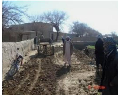
Altro importante traguardo di “edilizia pubblica” ha riguardato il Villaggio di Shirak ed è consistito nella **pulitura di 10 km di canale di irrigazione**. Attraverso la bonifica del canale, la popolazione di questo villaggio avrà la possibilità di irrigare **3.500 acri di terreno** per la coltivazione.
